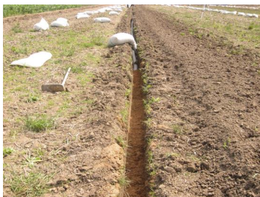
شکل ۲- پوسته برنج روی لوله زهکش کار گذاشته شده داخل ترانشه
