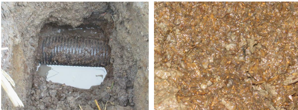
شکل ۵- پروفیل حفر شده روی یکی از لاترال‌ها و نمونه پوسته برنج موجود در اطراف لوله
